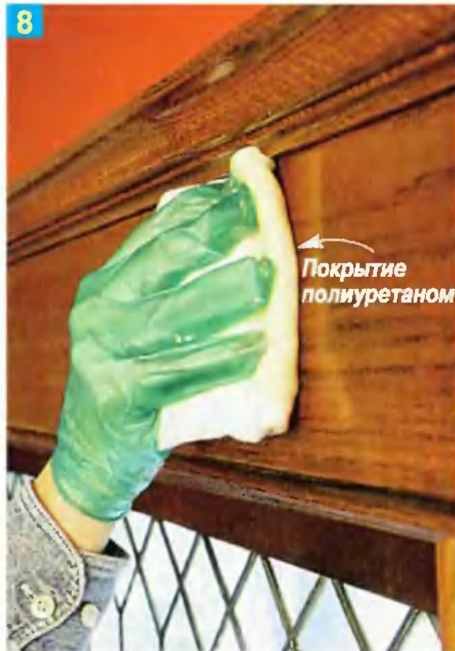
8 Восстановите блеск свежим слоем полиуретана. Нанесённый тампоном слой быстро даст гладкую поверхность, а подтёков будет меньше, чем при покрытии кистью.
