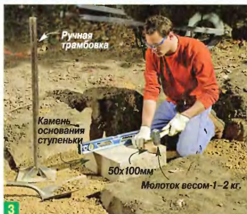
Рис. В. Три этапа постройки лестницы.
